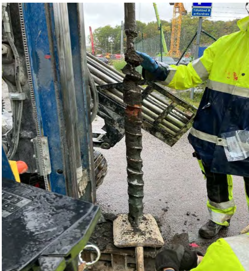
Figur 7. Borrbandvagn med monterad provtagningsskruv i provpunkt 22M27J.
